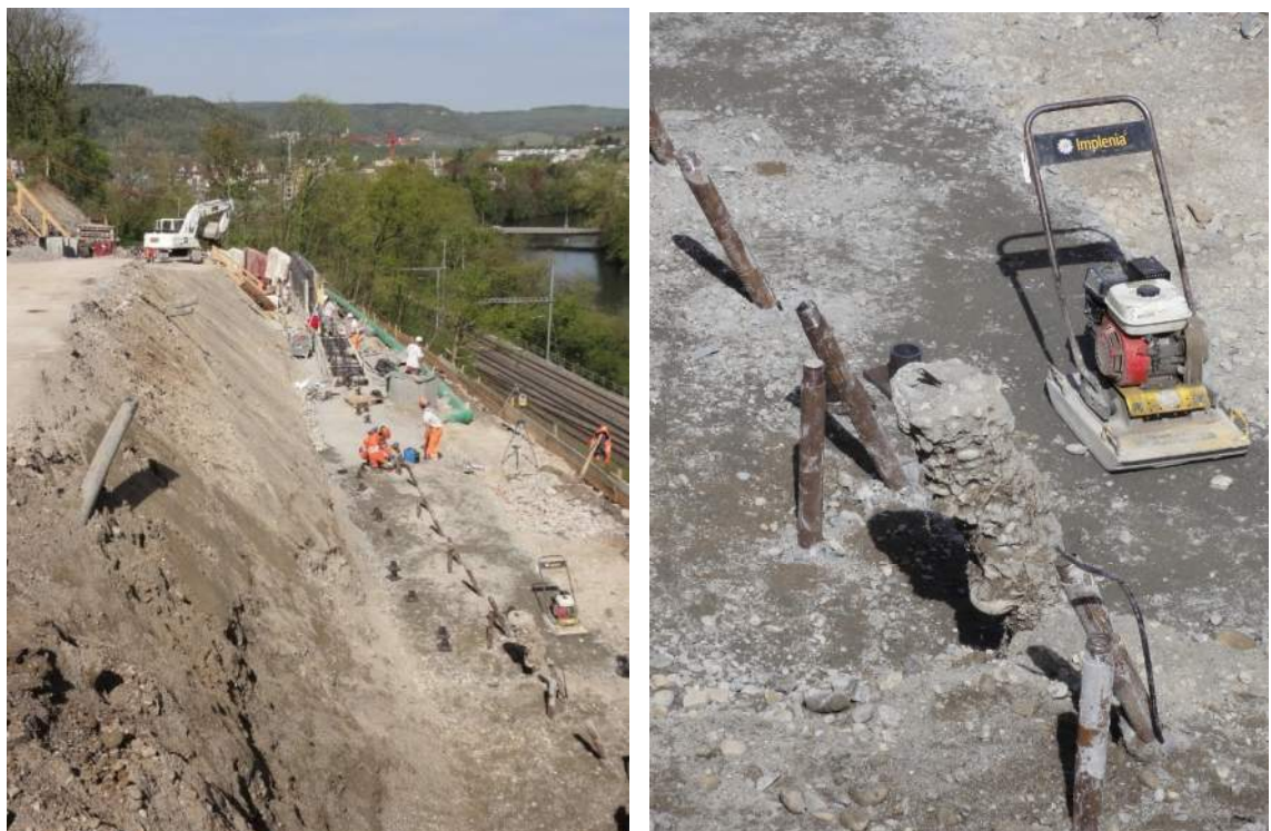
Foto 6: Mikropfähle für talseitige Stützmauer Wildenstich
