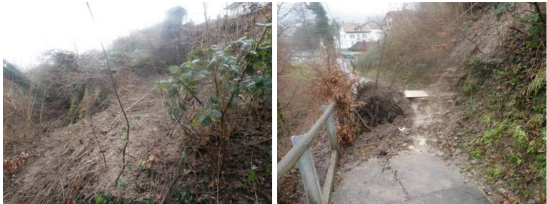
Fotoserie 4: ausgeknickte KS-Mauer bei Sitzbank am Teufelsweglein
