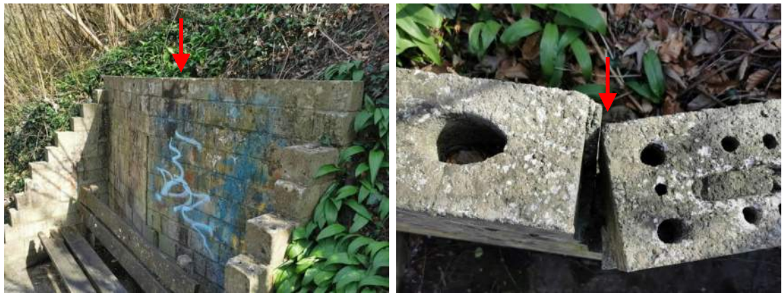
Fotoserie 4: ausgeknickte KS-Mauer bei Sitzbank am Teufelsweglein
