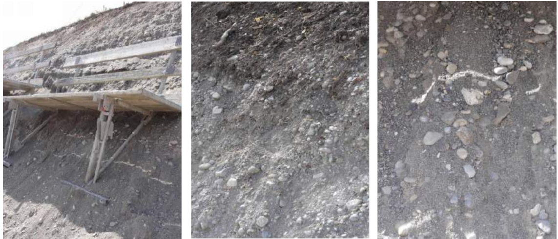
Foto 1: Schotteraufschluss beim Wildenstich
