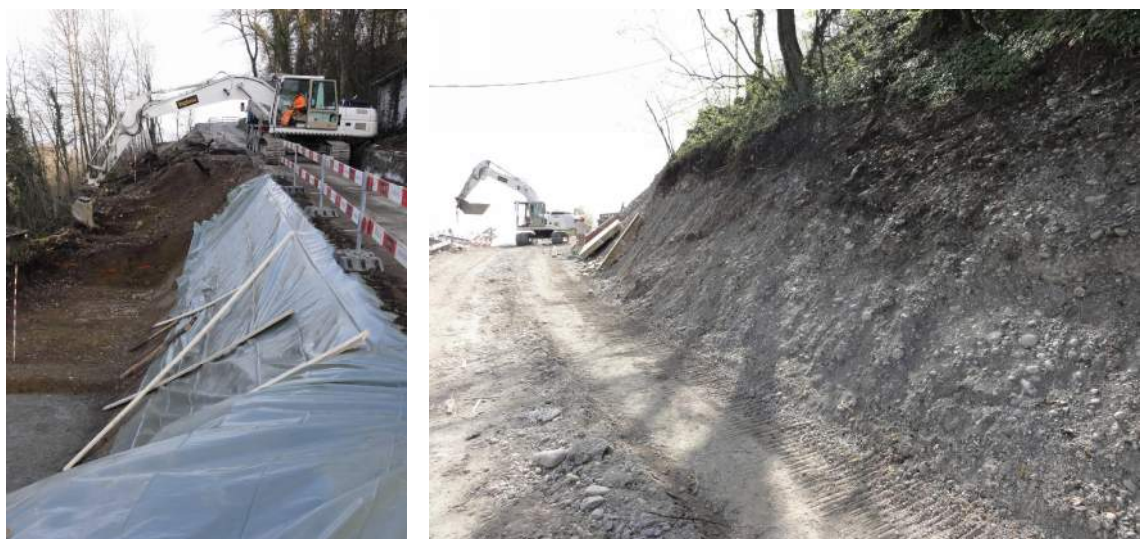
Foto 5: Geböschte Geländeanschnitte für Stützmauern Wildenstich (ohne Strassenverkehr)
